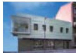
Japan Restaurant "My Sushi", Milano, I Studio di Architettura Clerici, Gallizia Tutucci, Milano Copermont S.r.l., Clusone (BG) TECU® Zinn
