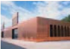
Service Centre Theresienwiese, Munich, D Volker Staab Architekten, Berlin Regensburger Metallbau, Regensburg TECU® Classic
